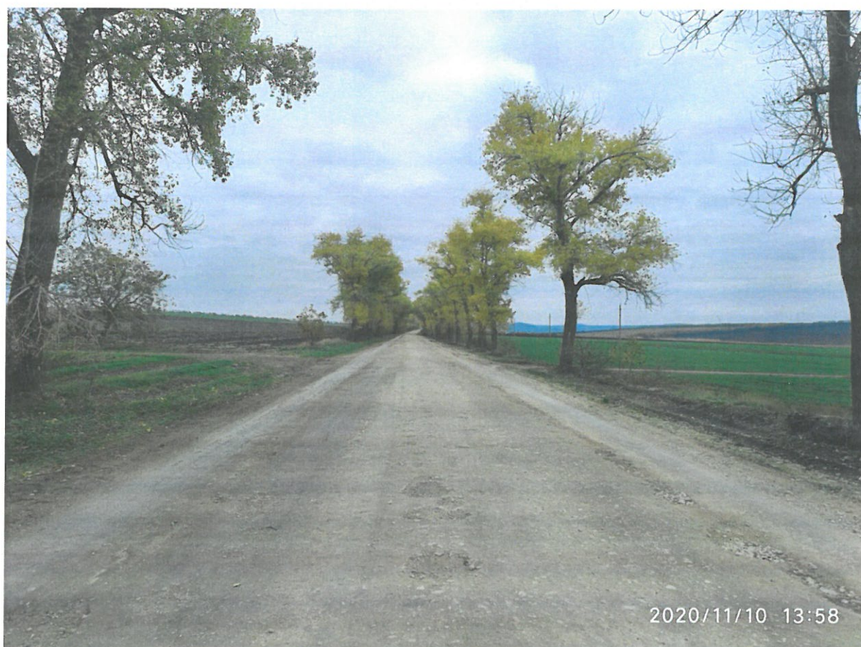
Figura 3.1. Km 27+600, gropi, nămol și resturi vegetale prezente pe partea carosabilă.
