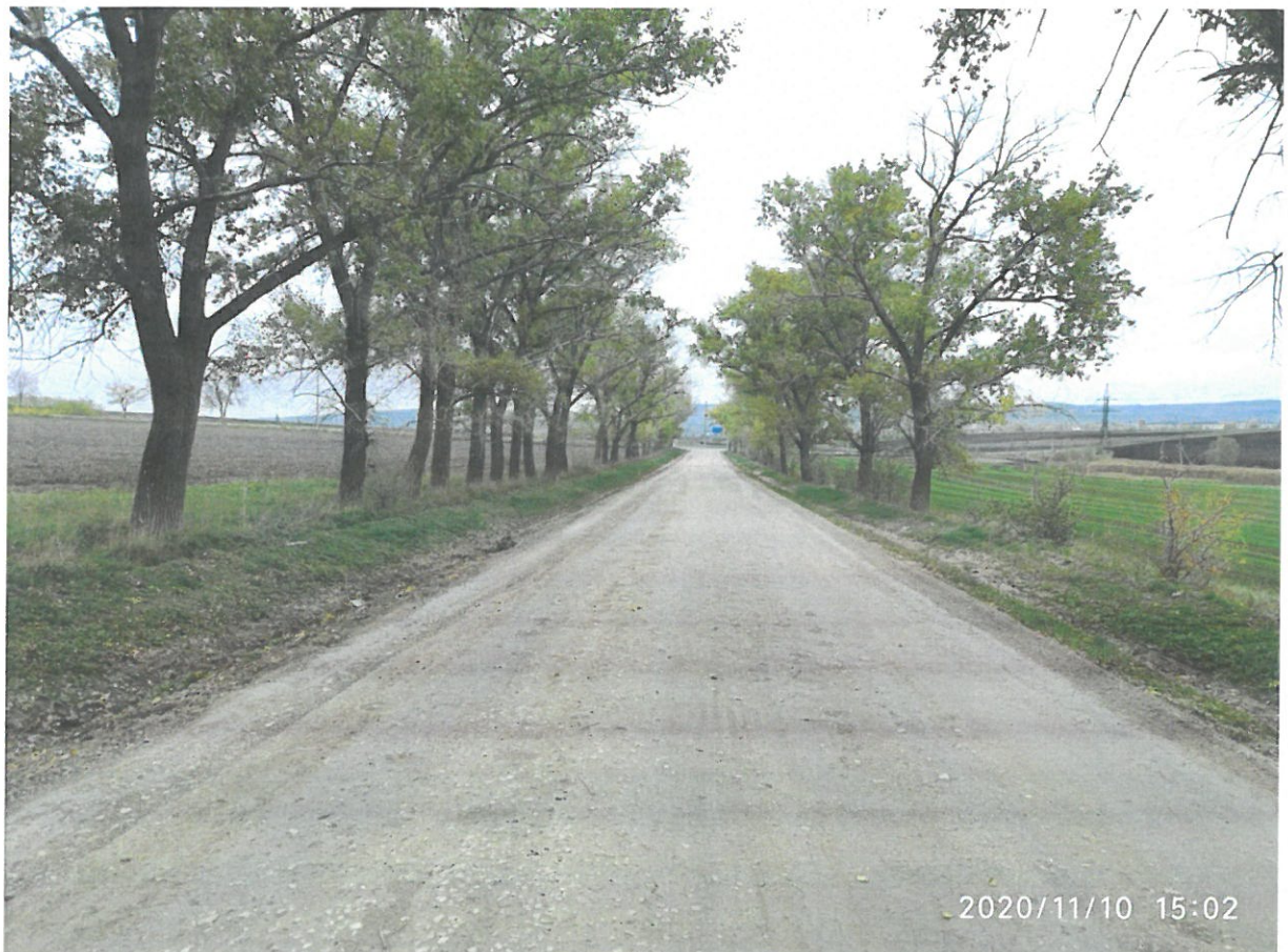
Figura 1.58. Km 30+800, fâgaș pe partea stîngă
